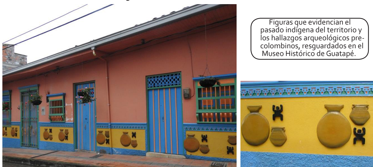
Imagen 2. Casa ubicada en la calle Giraldo
